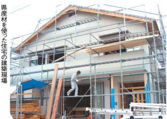
県産材を使った住宅の建築現場 松江市松江北
